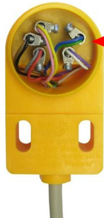
Einblick in einen geöffneten Trockenheizschutz/ Niveau-Stabelektroden-Anschlusskopf. Ersichtlich sind die übersichtlich, montagefreundliche und leicht zugänglich angeordneten Klemmen.
